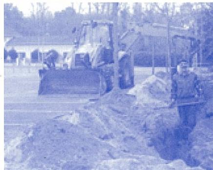
EDF procédera au raccordement et éliminera la ligne aérienne actuelle du poste de Tambour à St Justin. Cette réalisation sécurisera incontestablement la distribution de courant dans ce secteur puisque la ligne enterrée se moquera des chutes d'arbres ou de branches. Quant à la disparition des pylônes, elle ne peut qu'améliorer la qualité de l'environnement.
